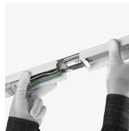
Der Montageprozess ist äußerst intuitiv. Er beginnt mit der Verbindung der Trägerprofile und deren Befestigung an der Decke. (Aufputzmontage oder mit Aufhängehaltern). Dank der Verschiebbarkeit von Halterungen über die gesamte Länge des Profils ist keine exakte Positionierung der Montagebohrungen erforderlich.
